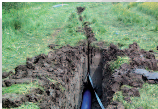
Oberfläche nach der Verlegung einer Trinkwasserleitung 250 x 14,8 mit dem Raketenpflug.
