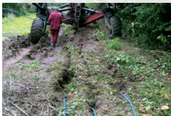
Einpflügen von Kollektorleitungen PE-HD DA 32 mit 50 cm Abstand.
