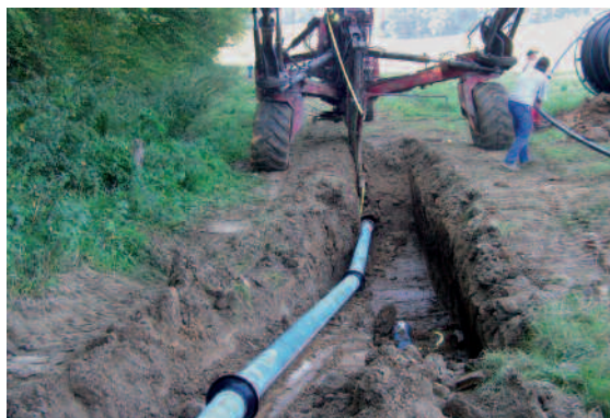
Startgrube und Raketenpflug beim Einziehen einer Gussleitung DN 150.
