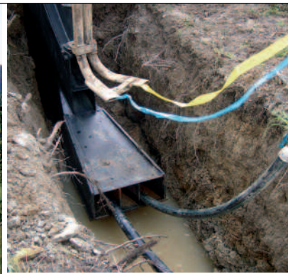
Verlegeschant für parallele Verlegung der Leitungen nebeneinander.
