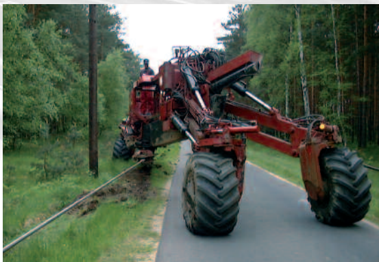
Einpflügen einer Trinkwasserleitung PE-HD DA 160.
