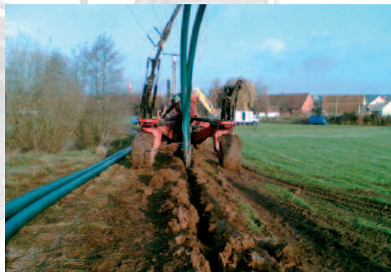
Einpflügen zweier Abwasserdruckleitungen PE-HD DA 225.
