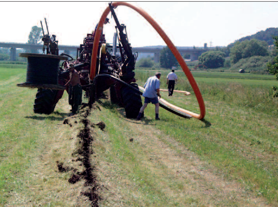
Einpflügen einer Gasleitung PE-HD DA 180, Steuerkabel und Dreifachschutzrohr 3 x 50.
