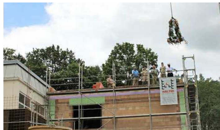
Richtfest auf dem Ebermannstadter Milchhof
